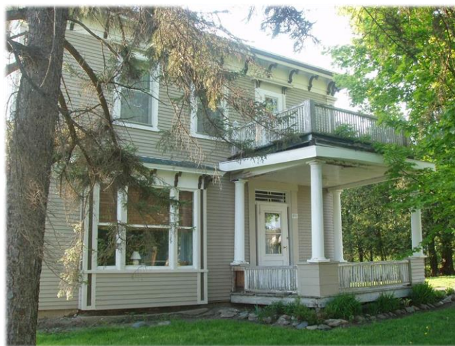
Maison patrimoniale au 283, rue Principale Heritage building, 283 rue Principale
